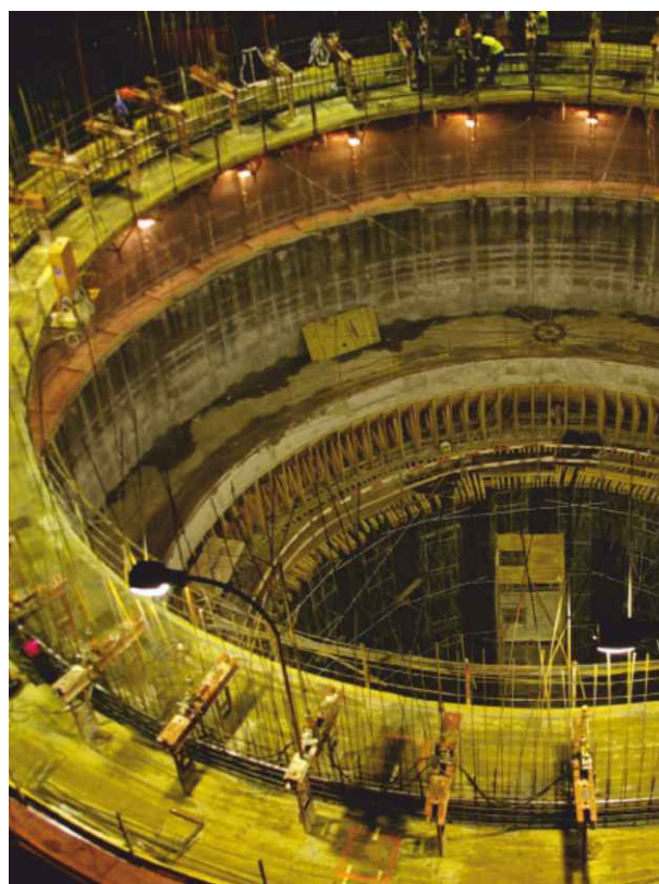
Zbiornik retencyjny popiołu w trakcie budowy.
