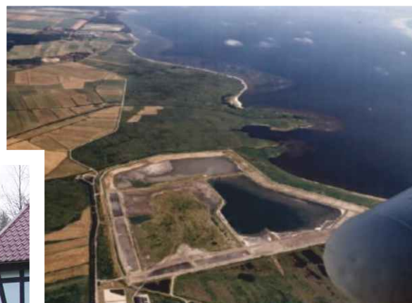
Składowisko odpadów paleniskowych w Rewie
