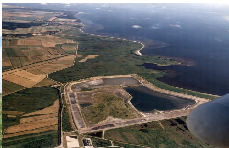
Składowisko odpadów paleniskowych w Rewie
