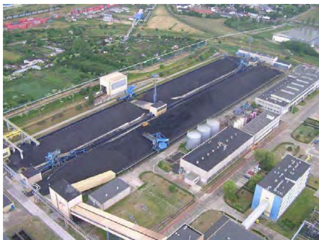
Plac składowania węgla w Elektrociepłowni Gdyńskiej
