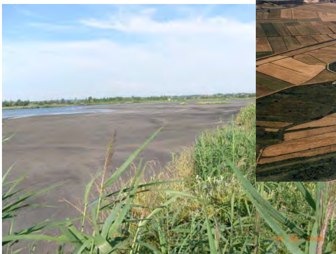
Składowisko odpadów paleniskowych w Letnicy
