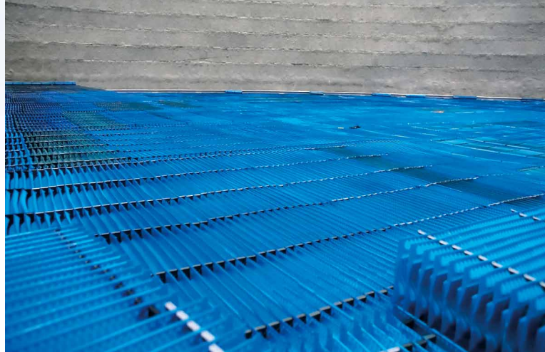
Eliminator unosu kropel z góry
