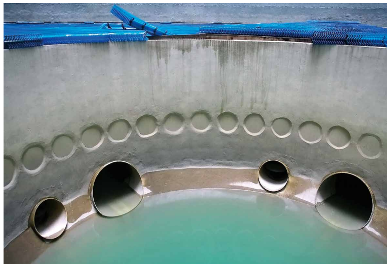
Kielich rozplywowy chłodni
