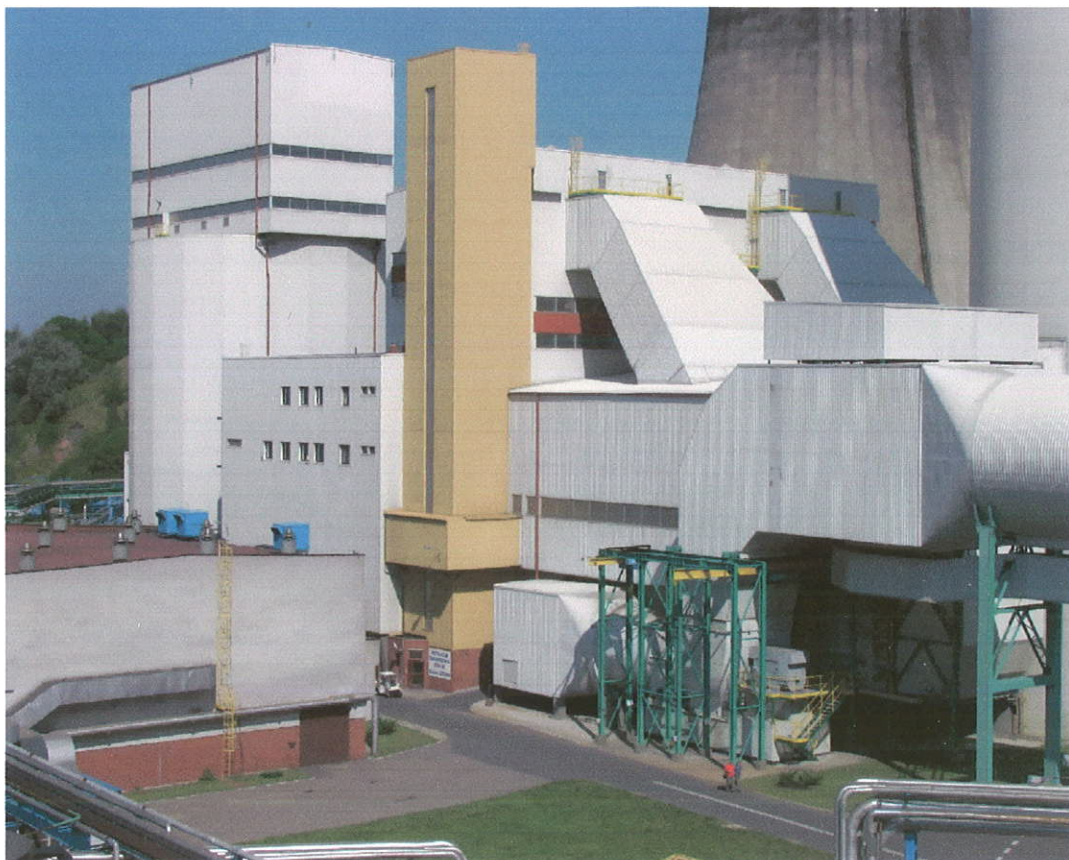
Instalacja odsiarczania spalin bloków 225 MW
