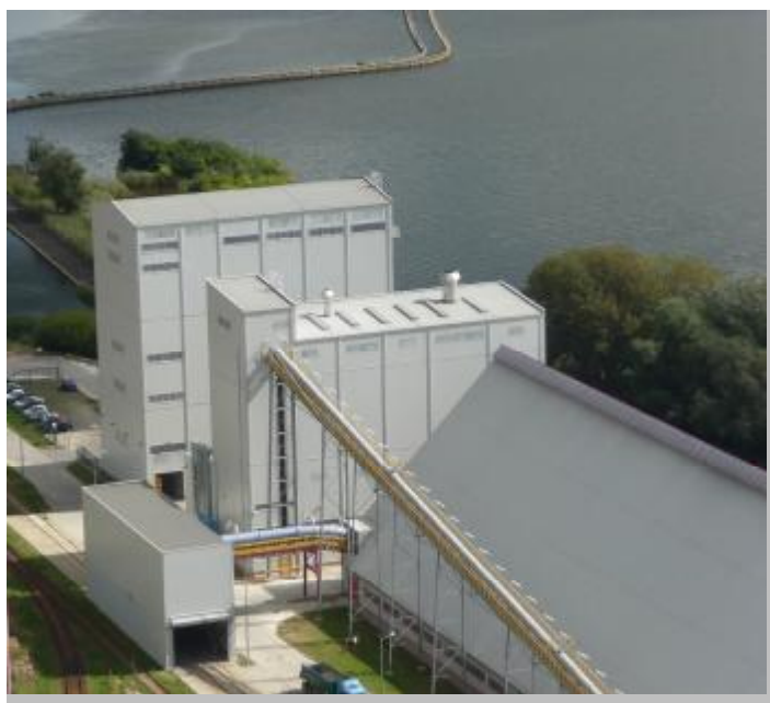
Instalacja Zakładu Przerobu Gipsu w Koninie
