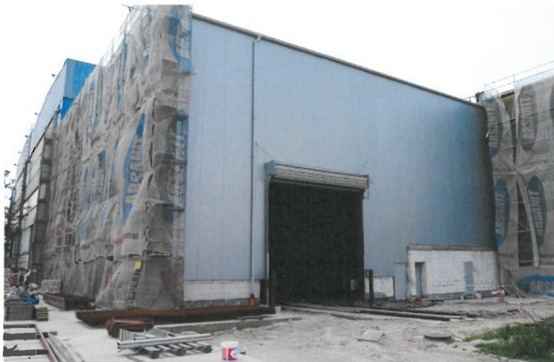
Zdjęcie nr 11.1 Budowa malarni – etap I część budowlana – rozbiórka i adaptacja
