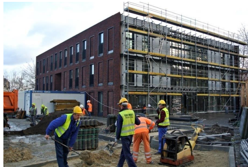
Siedziba WFOŚiGW w Gdańsku – w trakcie budowy
