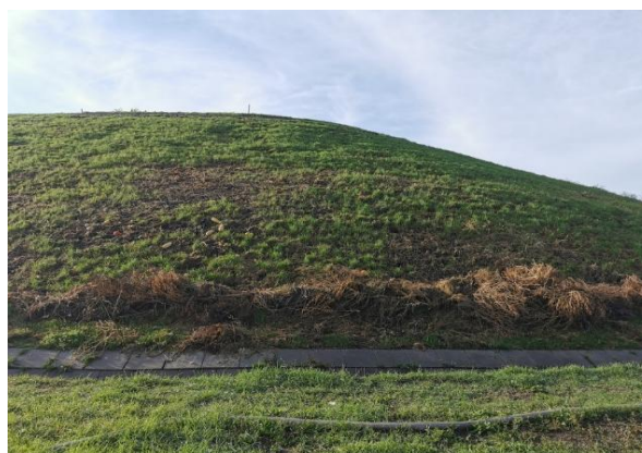
Zrekultywowane Składowisko Odpadów
