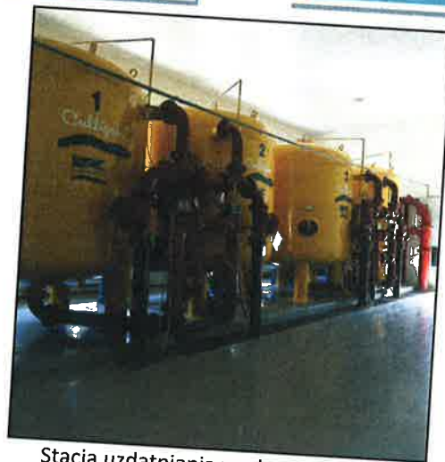
Stacja uzdatniania wody „Centralna”
