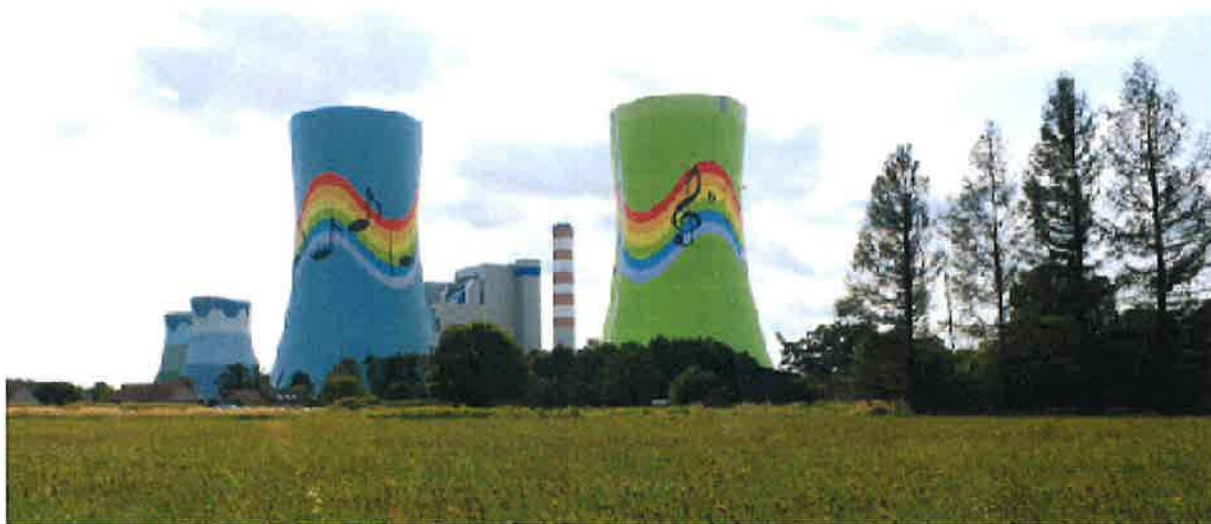
Fot. nr 3. Elektrownia – widok od chłodni kominowych bloków 5 i 6
