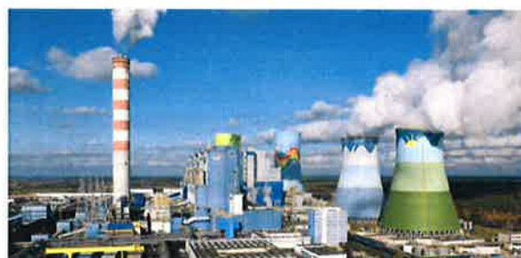
Fot. nr 2. Elektrownia Opole
