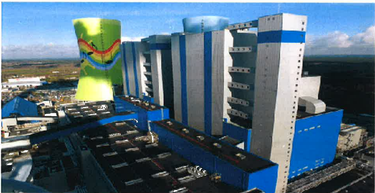
Fot. nr 4. Bloki energetyczne nr 5 i 6 oraz chłodnie kominowe nr 3 i 4
