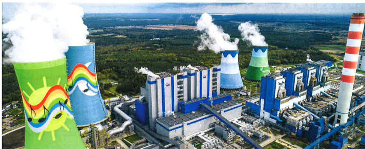
Fot. nr 1. Elektrownia Opole
