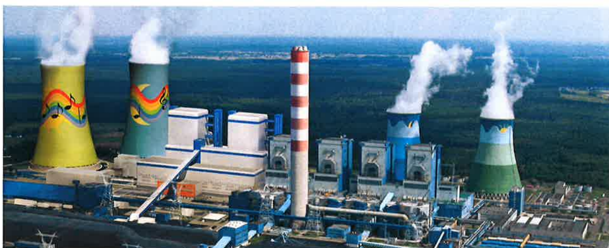
Fot. nr 10. Elektrownia Opole
