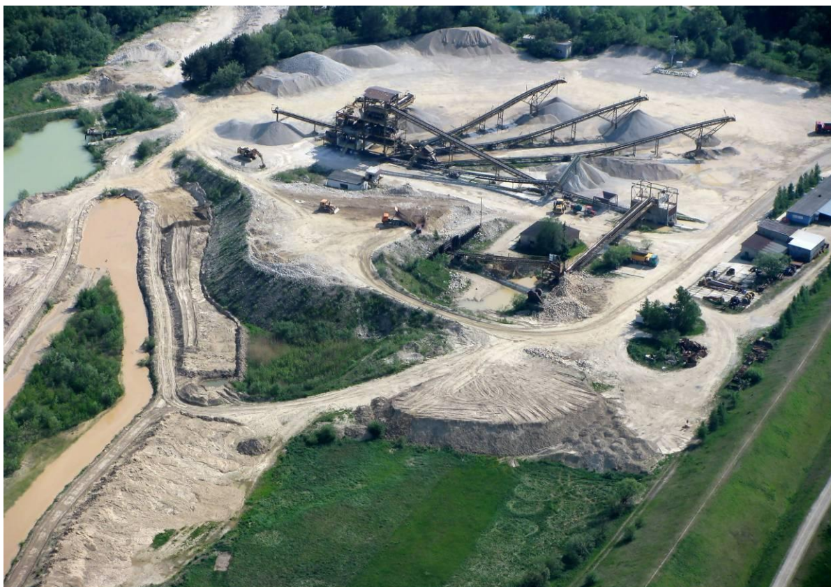
ZEK Dębno – teren zakładu przeróbki kruszyw
